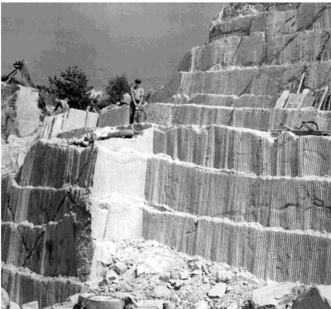
**Abb. 42:** Abbauarbeiten im Kapfenbergbruch mit dem sogenannten Schrämlverfahren.
