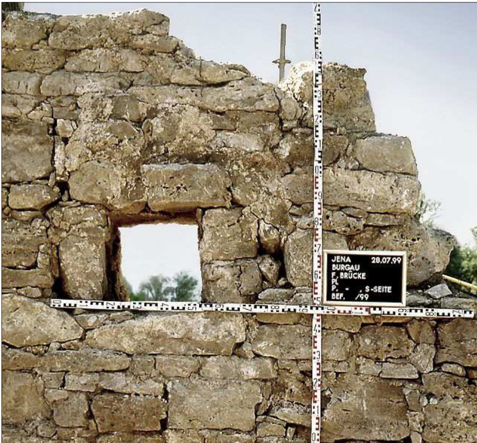
Abb. 5: Burgau, Saalebrücke, bodentiefe Öffnung in der südlichen Brückenwange.
