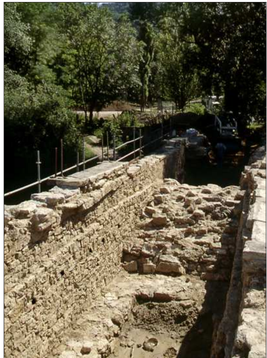
Abb. 3: Burgau, Saalebrücke, Mauerwerksgefüge aus unregelmäßigem Bruchstein. Die Pfeile markieren die Balkenlöcher der Schwellen des Fahrbahnunterbaus.
